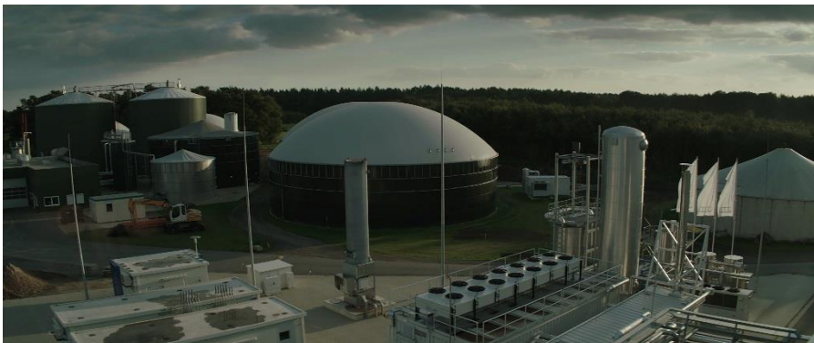
07 In der weltweit größten Power-to-Gas-Anlage im niedersächsischen Werlte wird mit überschüssigem Strom ein nachhaltiger Kraftstoff hergestellt. ©change filmverleih
